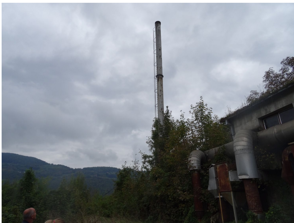
Slika 2.2. Izgled objekta na kojem se implementira projekat
