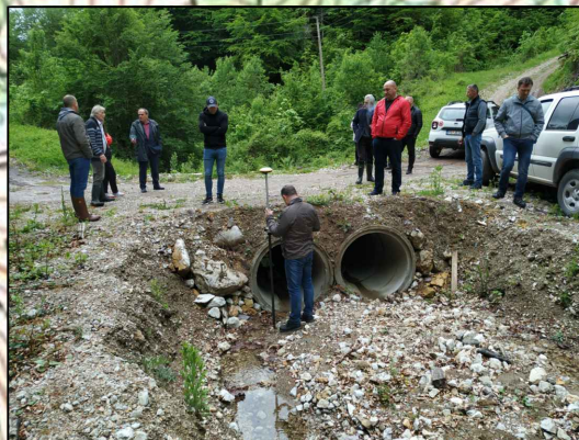
Lokacija uzvodno od vodozahvata na koti terena cca 1131,00 mnm
