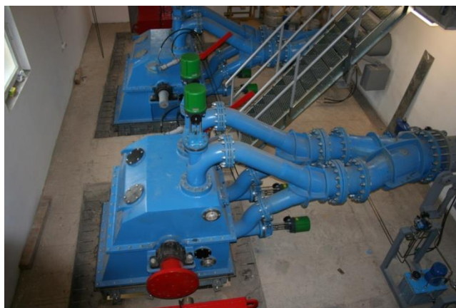
Slika 31. Primjer Pelton turbine sa horizontalnim vratilom
