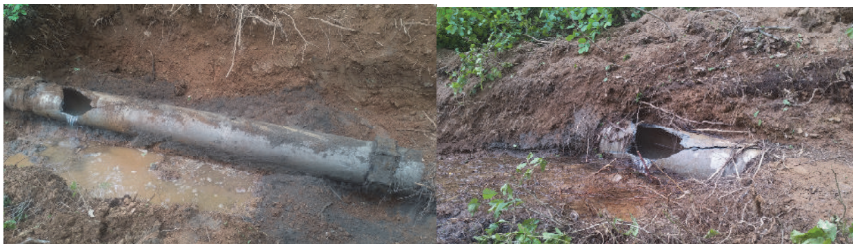
Slika 7 i 8: Popravka kvara na ACC Ø300mm u mjestu Ravna Rijeka – iznad želj. Pruge
