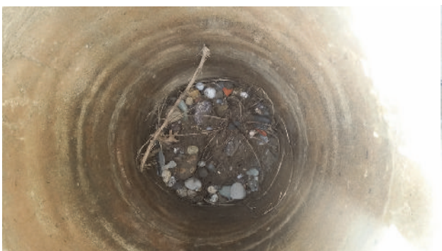
Slika 21 i 22: Čišćenje revizionog okna na kanalizacionoj mreži u krugu fabrike „Imako“
