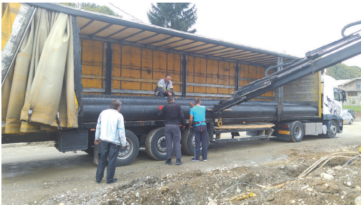
Slika 4.: Zamjena ACC Ø500mm sa ČC 500mm, mjesto Rakonje (nova raskrsnica kod zaobilaz.)
