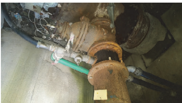
Slika 19 i 20: Popravka i zamjena ispusnog ventila na magistralnom cjevovodu ACC Ø500mm
