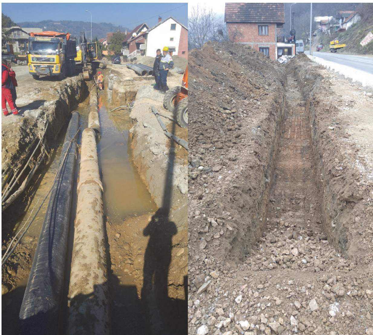
Slika 1 i 2: Rekonstrukcija glavnih distributivnih cjevovoda ACC Ø500mm i ACC Ø300mm
