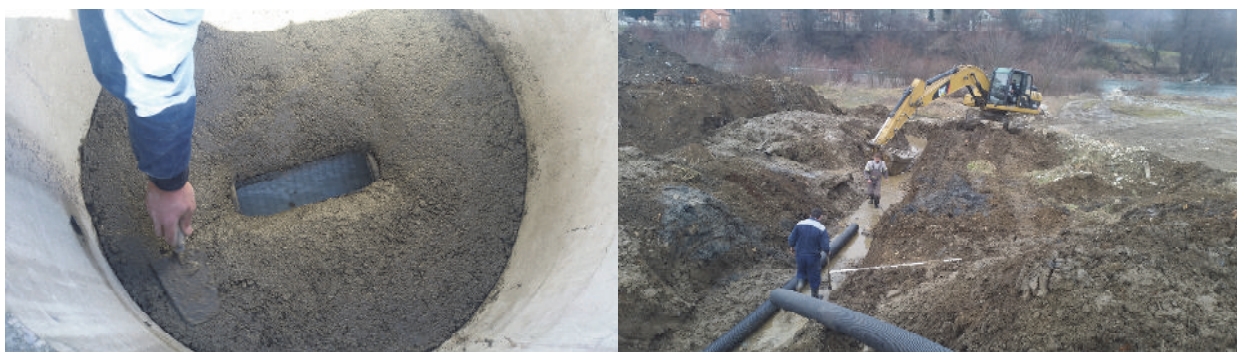
Slika 3 i 4: Rekonstrukcija kolektora – kanalizacije Ø250mm kod „IMAKA“ – Industrijska z.
