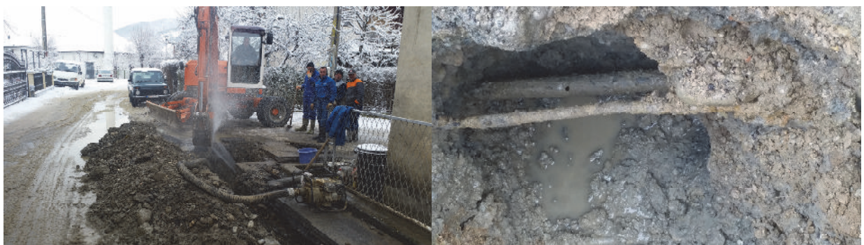
Slika 5 i 6: Popravka kvara u ul. Šukrije Međedovića kod kuće Radovića na PC Ø75mm
