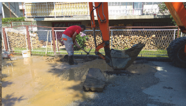
Slika 18: Popravka kvara na PC Ø50mm
