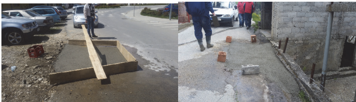
Slika 11 i 12: Betoniranje kvara u ul. Golootočkih žrtava i na Zaimovića Livade kod Avdića
