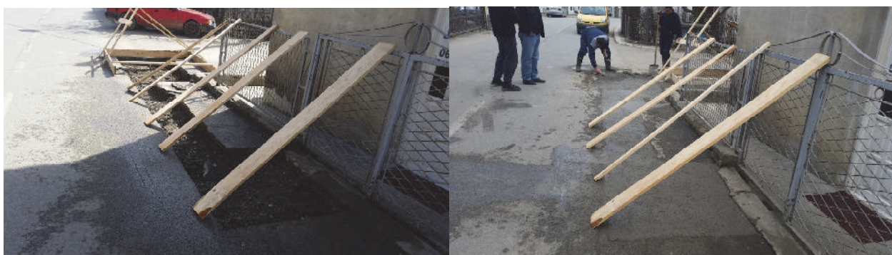
Slika 13 i 14: Betoniranje kvara u ul. Šukrije Međedovića kod kuće Radovića
