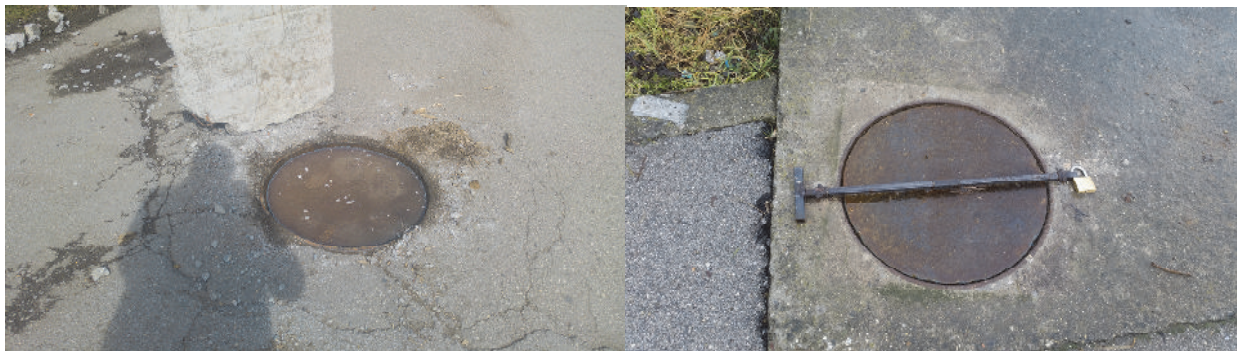
Slika 1.: Zamjena metalnog poklopca Ø60cm Slika 2.: Zamjena i zaključavanje met. poklop.
