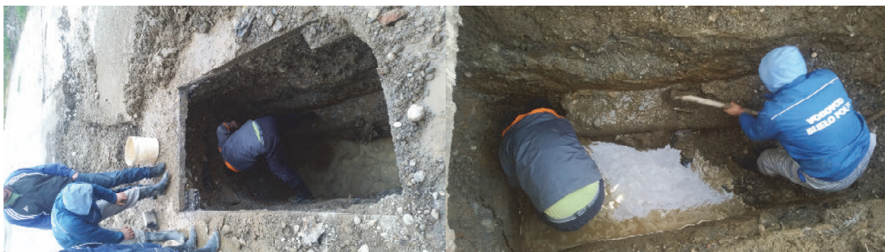
Slika 9 i 10: Popravka kvara na čeličnoj cijevi Ø150mm u Industrijskoj zoni kod Pošte 2
