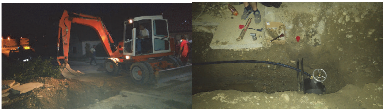
Slika 15 i 16: Popravka kvara kod kuće Kuruglića (iznad MUP-a) sa izradom novog priključka
