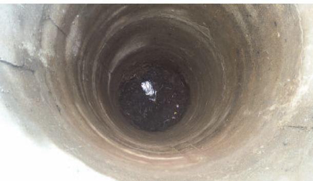
Slika 21 i 22: Čišćenje revizionog okna na kanalizacionoj mreži u krugu fabrike „Imako“
