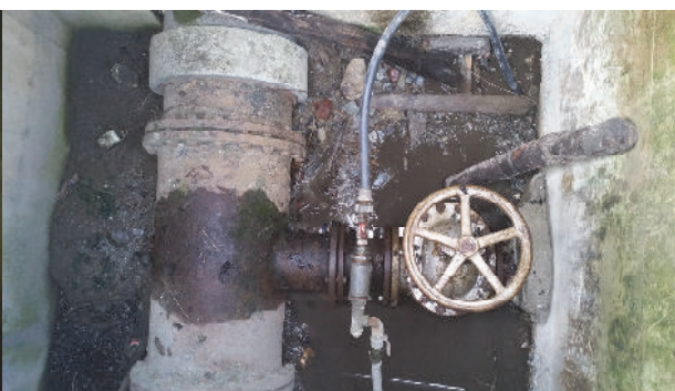
Slika 19 i 20: Popravka i zamjena ispusnog ventila na magistralnom cjevovodu ACC Ø500mm
