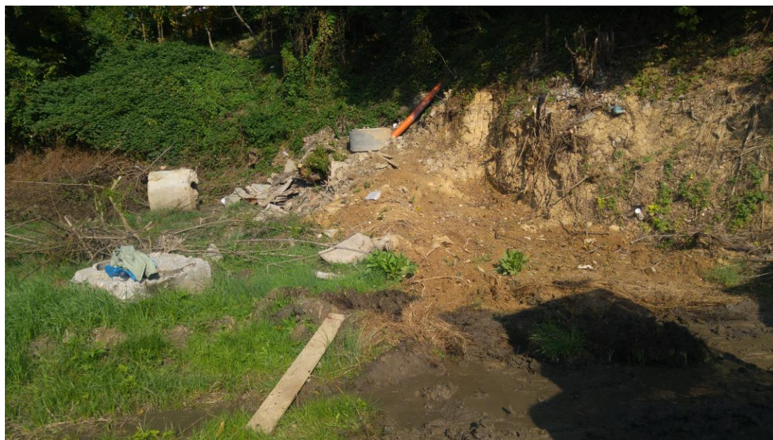
Slika 1: Radovi na sanaciji dijela kanalizacione mreže u Peroševića potok
