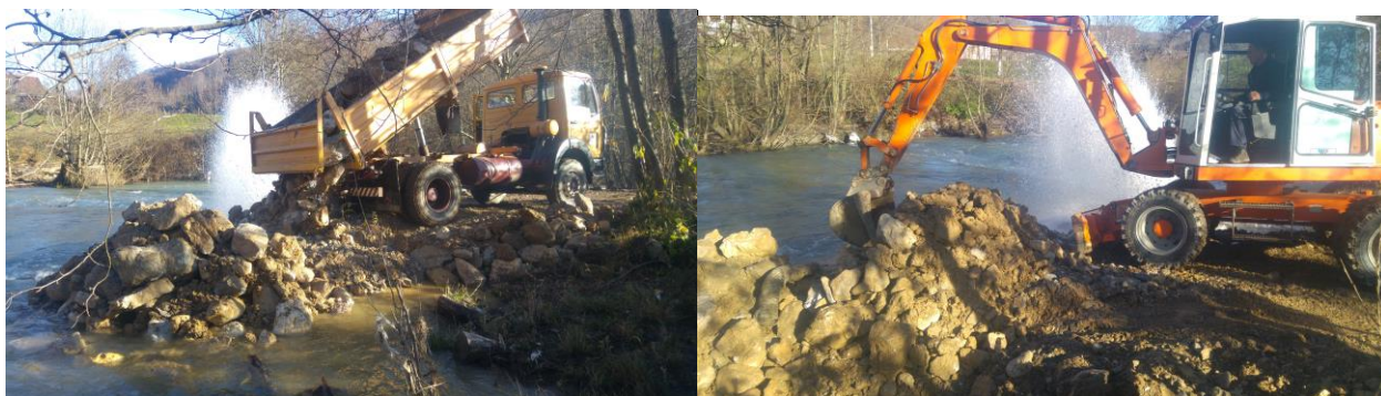
Slika 7 i 8.: Popravka kvara na ČC Ø300mm ispod korita rijeke Ljuboviđe – mjesto R. Rijeka
