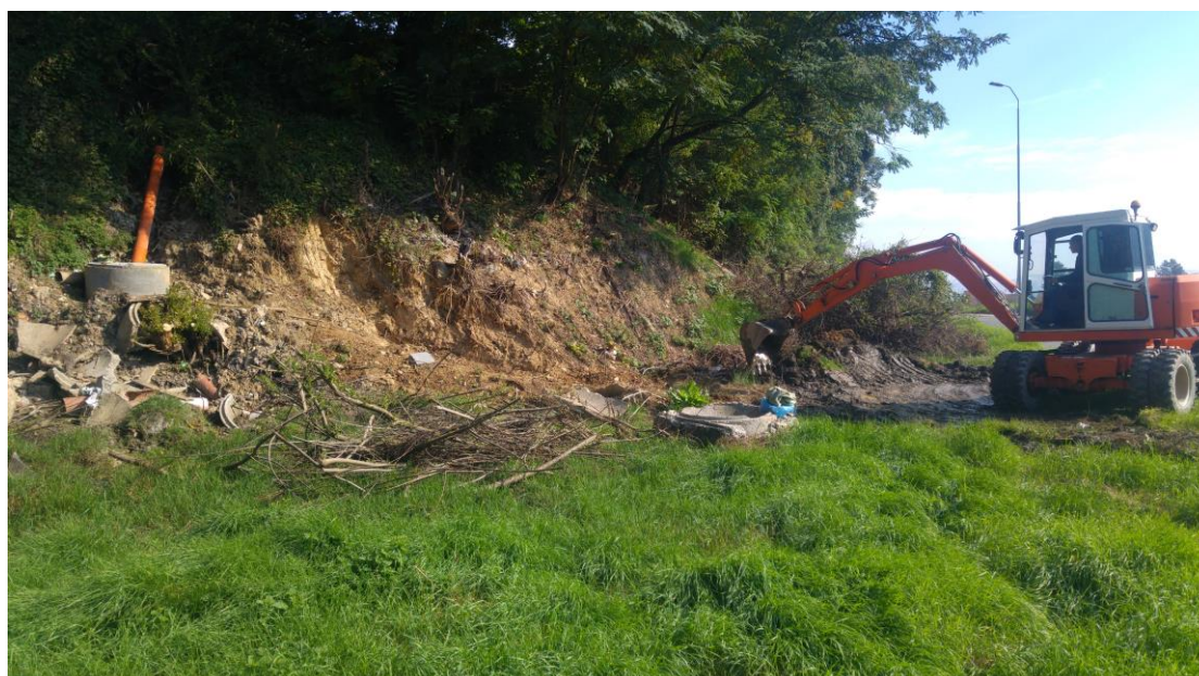
Slika 2: Radovi na sanaciji dijela kanalizacione mreže u Peroševića potok
