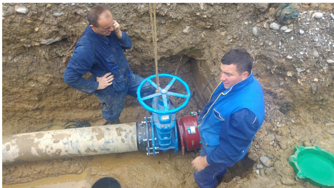
Slika 3.: Ugradnja ventila DN 300mm u Rakonjama kod romskog naselja
