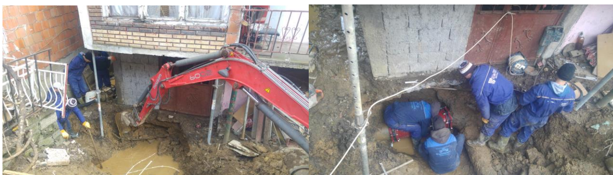
Slika 4 i 5.: Popravka kvara na ACC Ø300mm u Rakonjama (kod kuće Marije Božović)
