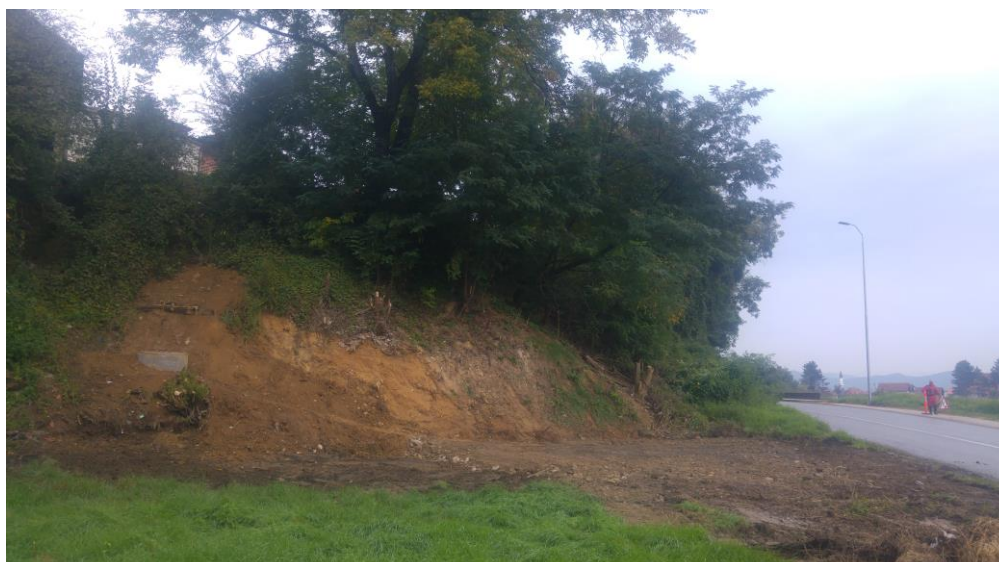
Slika 4: Radovi na sanaciji dijela kanalizacione mreže u Peroševića potok
