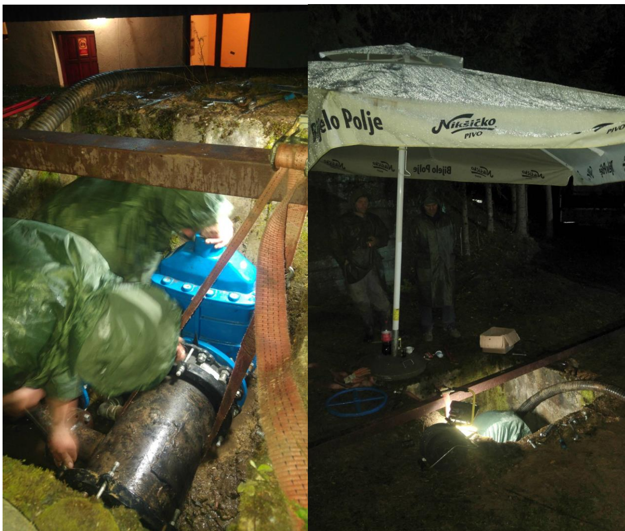
Slika 16 i 17.: Ugradnja zatvarača DN 300 na hlornoj stanici (Ravna Rijeka)
