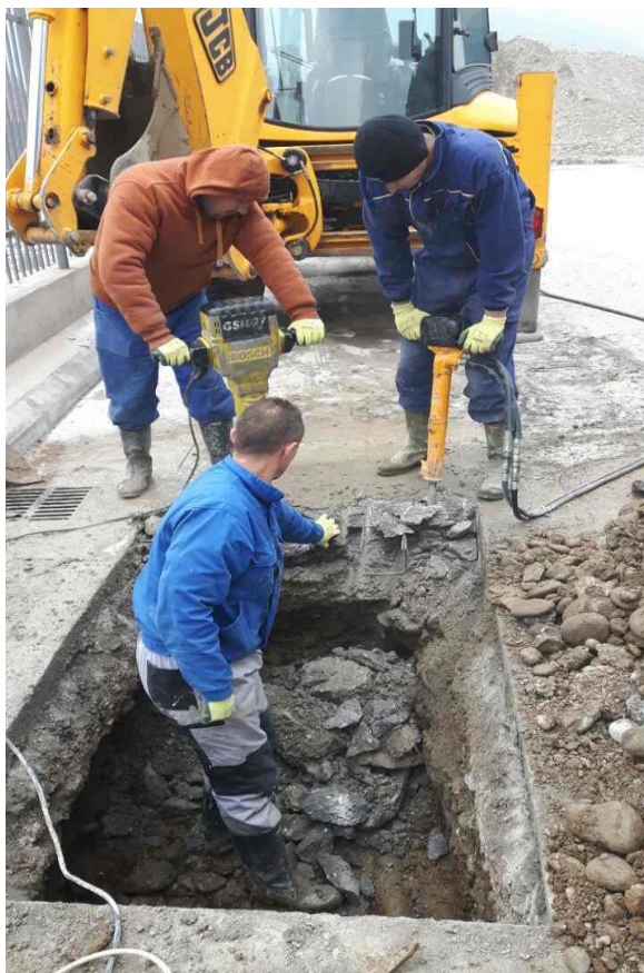
Slika 14.: Kvar na ACC Ø100mm u Potkrajcima
