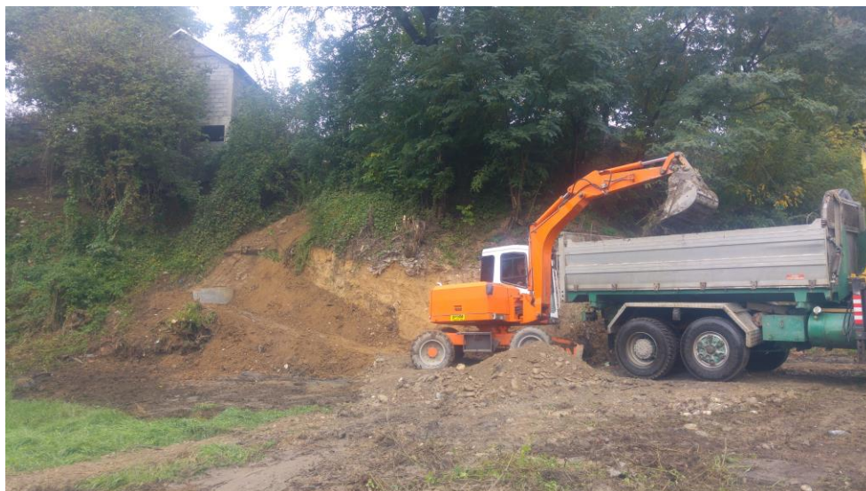
Slika 3: Radovi na sanaciji dijela kanalizacione mreže u Peroševića potok
