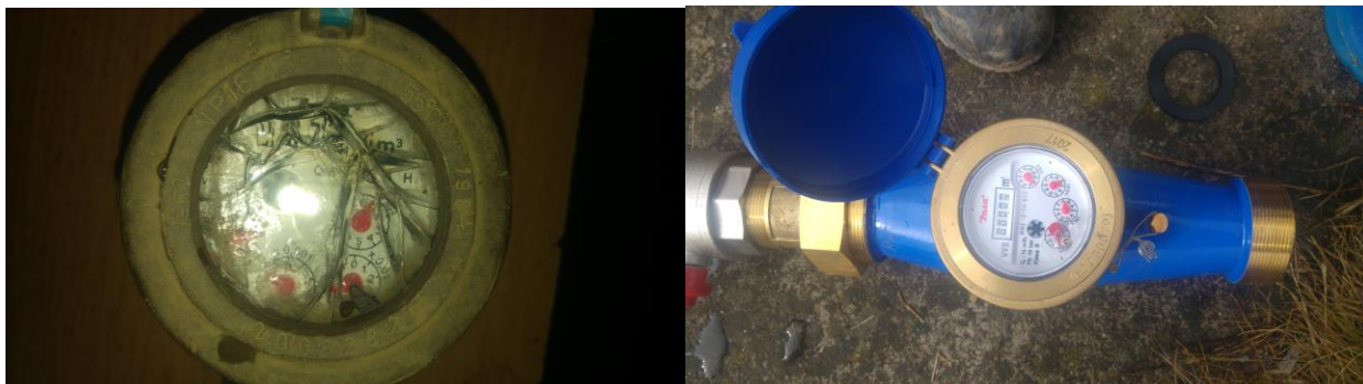
Slika: Zamjena i baždarenje vodomjera
