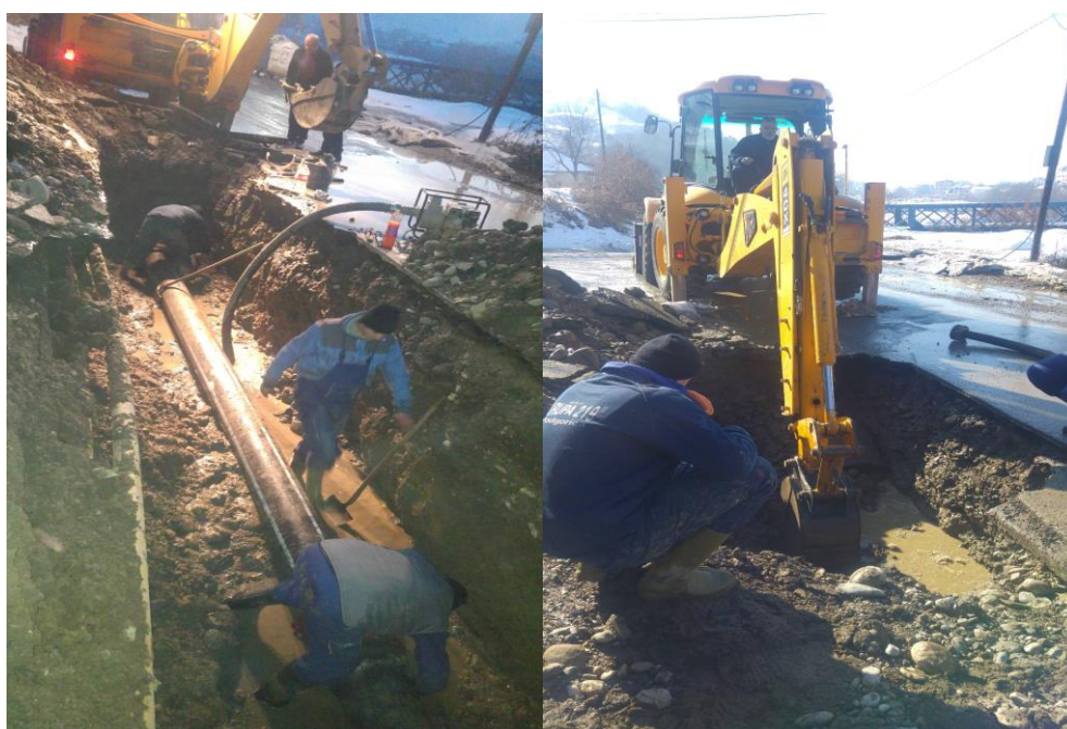
Slika 9 i 10.: Popravka kvara na PVC Ø315mm na Loznicama
