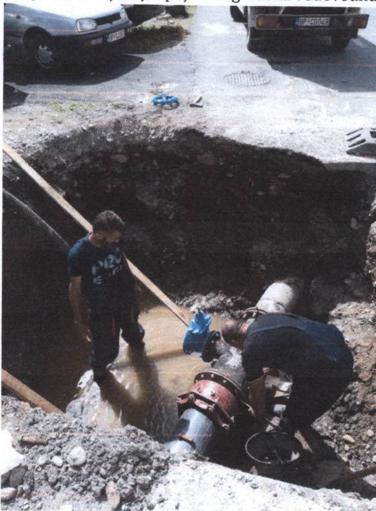
Slika u toku izvođenja radova na priključku za poslovni objekat "ETC Elkos"
