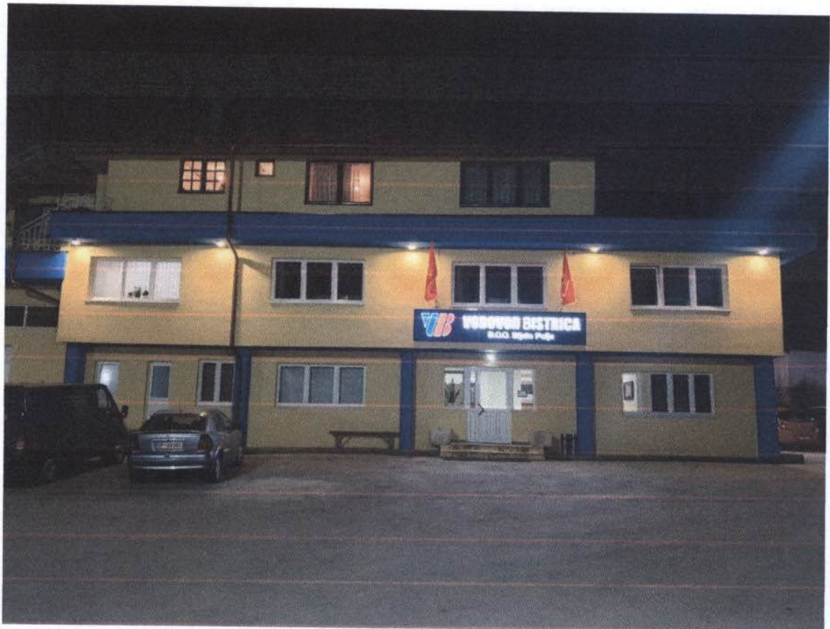
Slika upravne zgrade Vodovoda "Bistrica" nakon adaptacije
