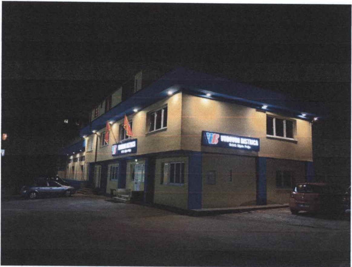
Slika upravne zgrade Vodovoda "Bistrica" nakon završene adaptacije
