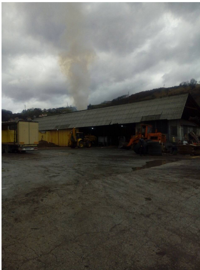
Slika 6. Montažni objekat u kojem je smješteno postrojenje za proizvodnju peleta
