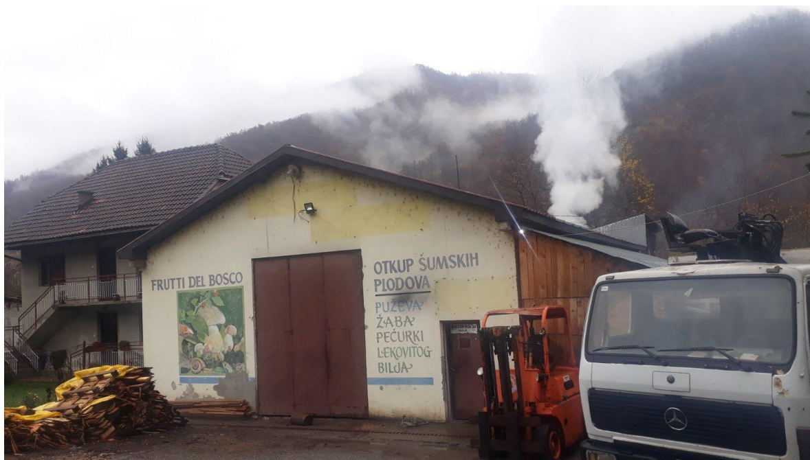
Slika 3. Izgled predmetnog objekta i lokacije sa njenim okruženjem, oktobar 2019.godine
