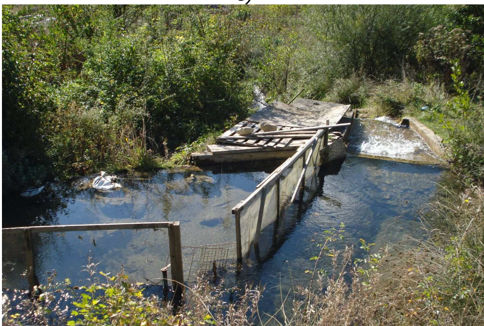
Slika 2. Postojeći vodozahvat za ribnjak
