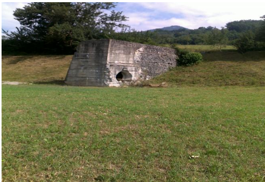
Slika broj 2: Ostaci hidrocentrale u selu Bistrica
