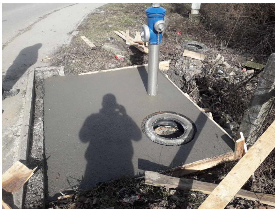
Slika: Sanacija AB šahte kod skretanja za Rasovo (kod raskrsnice – Hipermarket "VOLI")
