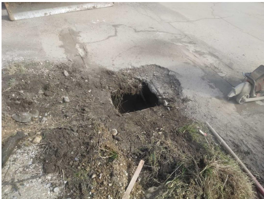
Slika: Sanacije šahte na vodovodnoj mreži u Rasovo (prije sanacije)
