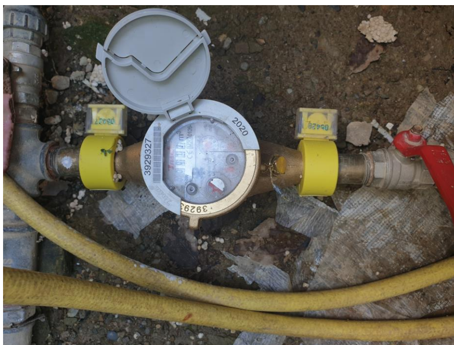
Slika: Baždarenje vodomjera sa kompletom za plombiranje (PVC plombe)
