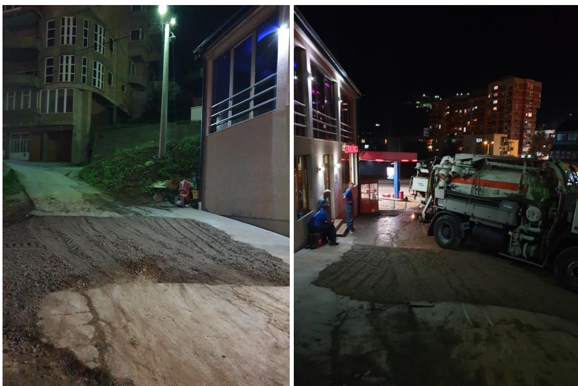
Slika: Sanacija vodovodne mreže ACC 200mm ispod objekta "Lejla"
