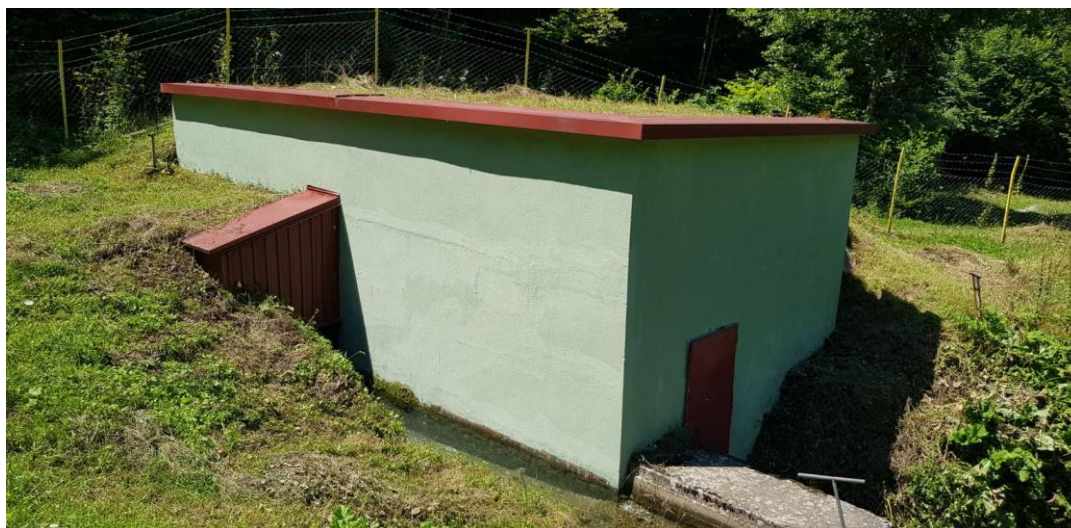
Slika: Redovno održavanje objekata na izvorištu – "Stari rezervoar"
