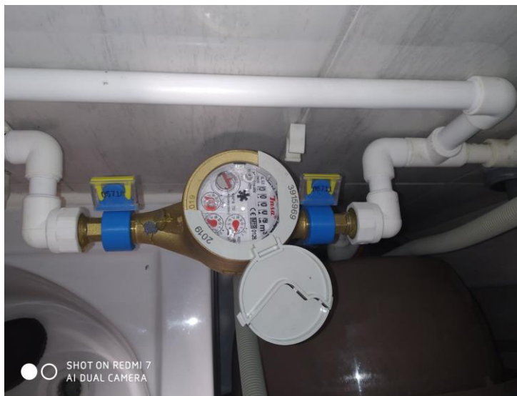
Slika: Zamjena vodomjera sa kompletom za plombiranje (PVC plombe)
