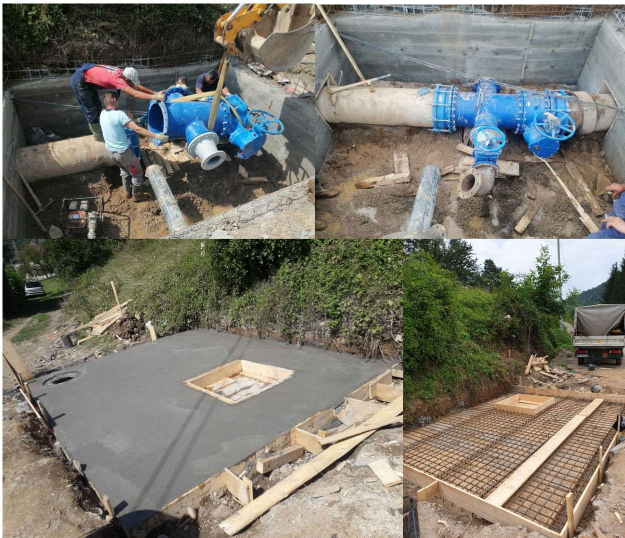
Slika: Izrada AB šahte i priključka za novi vodovod „Zaton“ – Ribarevine
