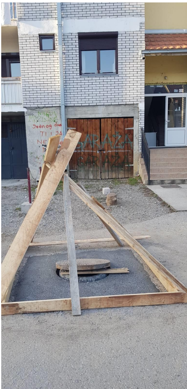
Slika: Sanacije šahte na kanalizaciji u ul. Milorada Šćepanovića (nakon sanacije)
