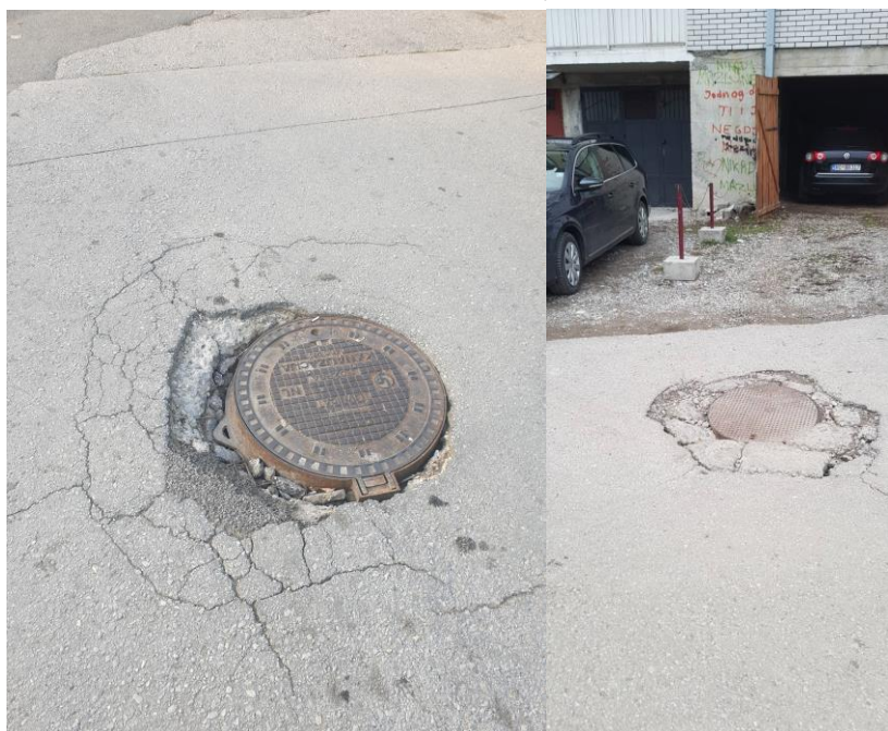
Slika: Sanacije šahte na kanalizaciji u ul. Milorada Šćepanovića (prije sanacije)
