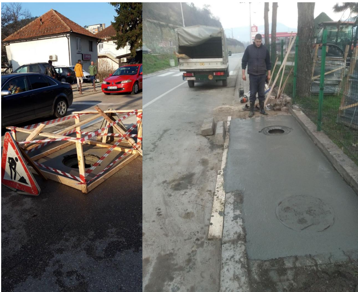
Slika: Sanacija AB šahte na vodovodnoj mreži u ul. Tršovoj (lijevo) i Voja Lješnjaka (desno)
