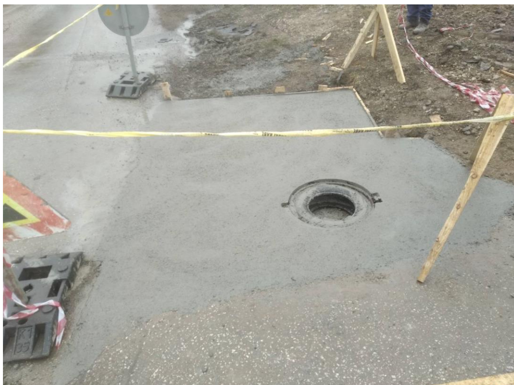
Slika: Sanacije šahte na vodovodnoj mreži u Rasovo (nakon sanacije)
