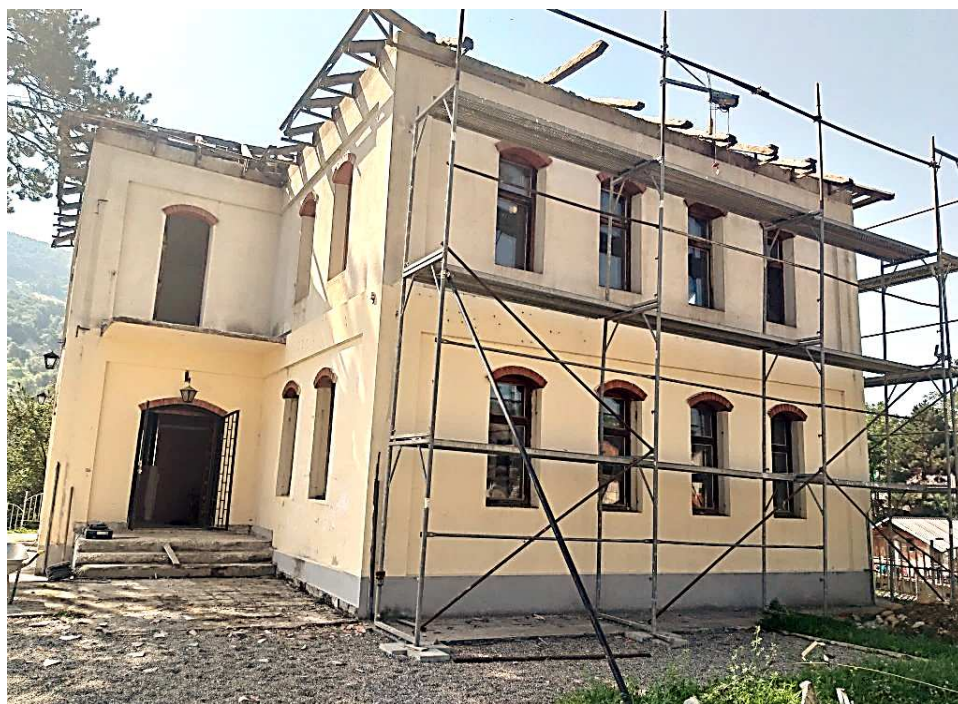
Rekonstrukcija zgrade muzeja, početak radova
