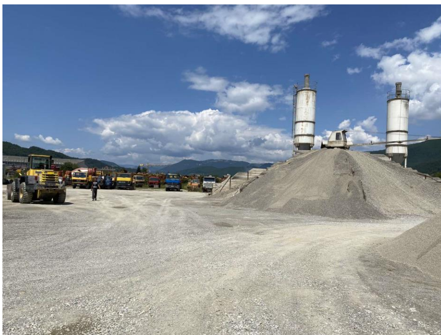
Slika 9. Postrojenje za separaciju šljunka i pijeska, avgust 2023.
