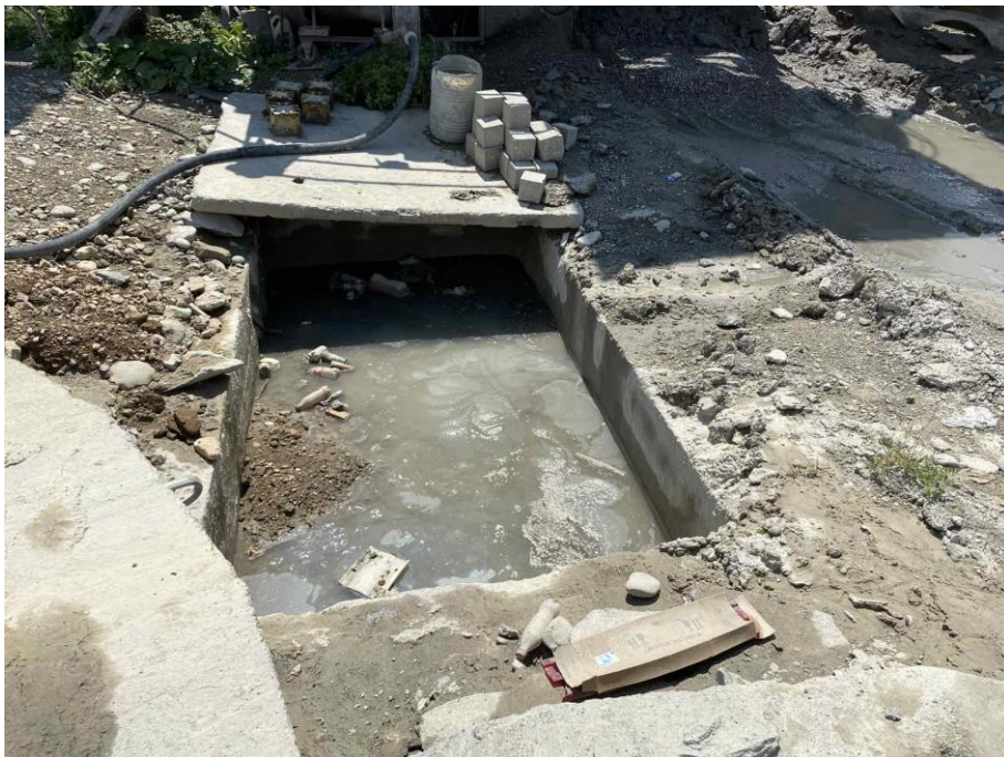
Slika 6. Taložnik-objekat za proizvodnju betona, avgust 2023.godine
