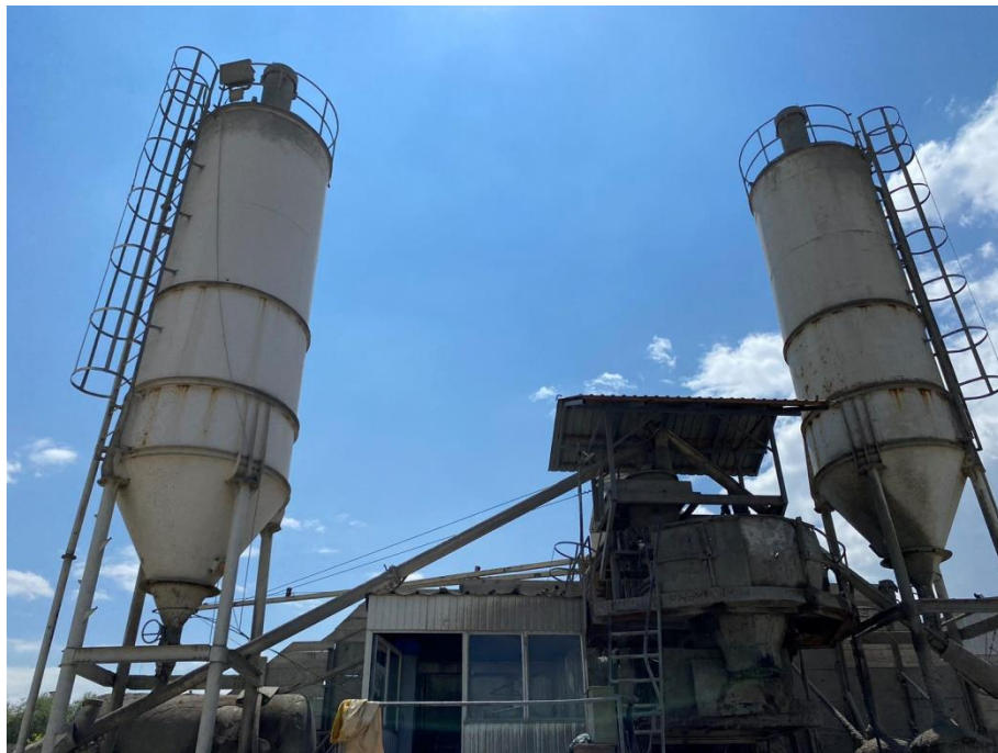
Sl. 24. Silosi za cement i objekat za proizvodnju betona, avgust 2023.
