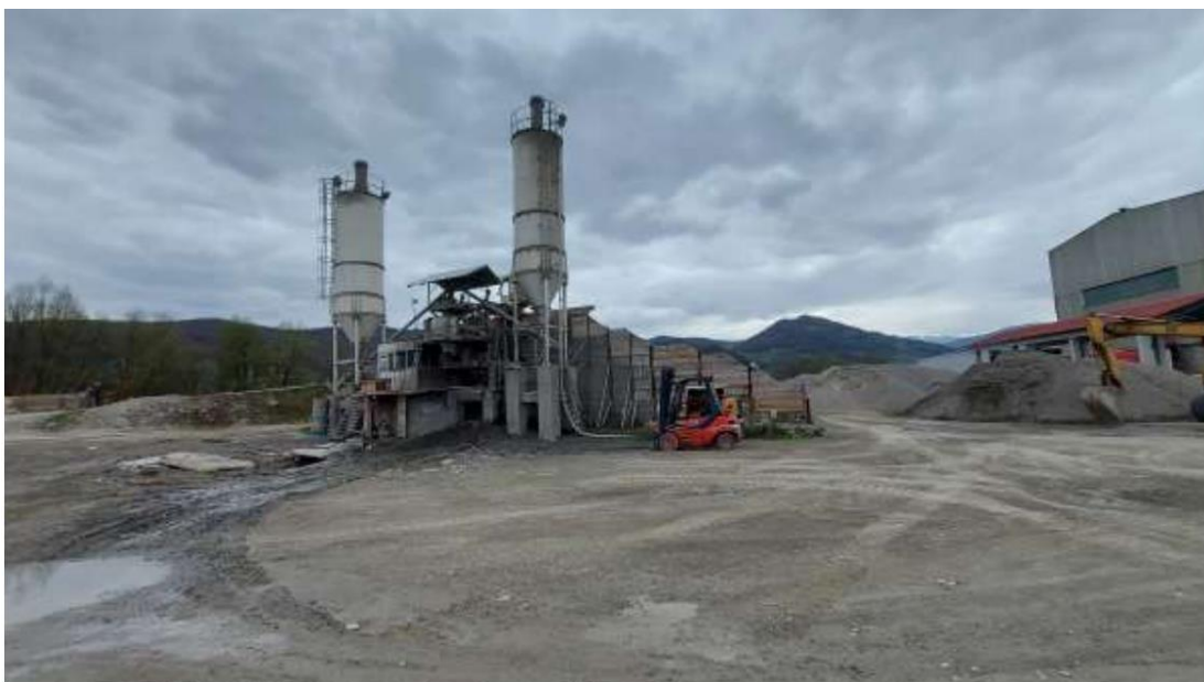
Sl. 26. Objekat za proizvodnju betona
