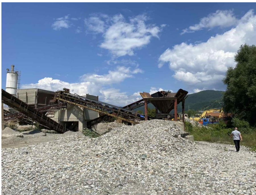
Slika 8. Postrojenje za separaciju šljunka i pijeska, avgust 2023.
