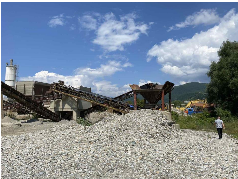
Slika 7. Postrojenje za separaciju šljunka i pijeska, avgust 2023.
