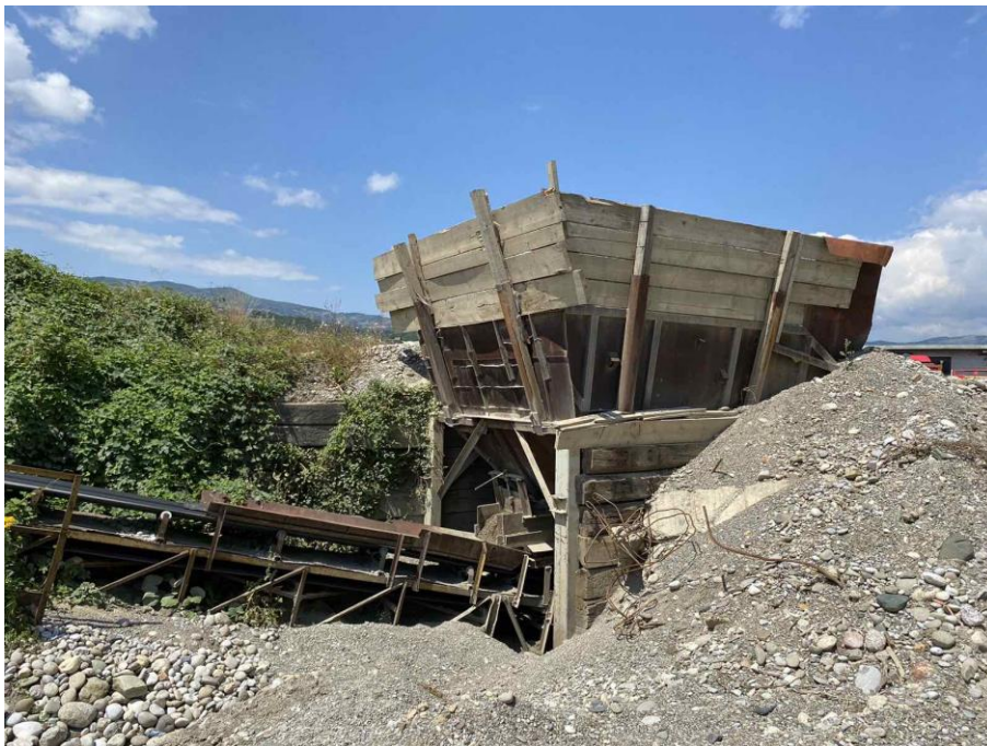
Slika 10. Postrojenje za separaciju šljunka i pijeska, avgust 2023.
